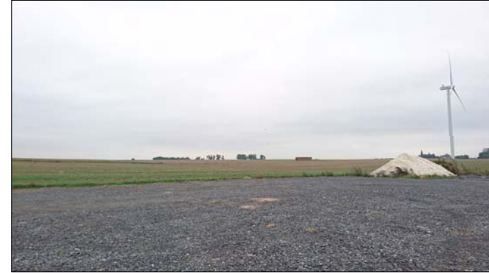
Figure 89 : Illustration d'un sol minéral appliqué à une plateforme de montage
